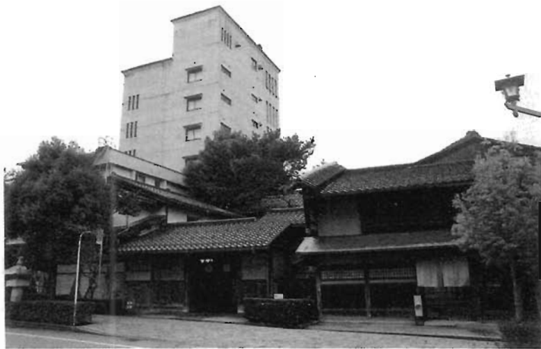
山代温泉の白銀屋。経営破綻後、2005年より星野リゾートの運営で再建。「白銀クラシック」と銘打った
